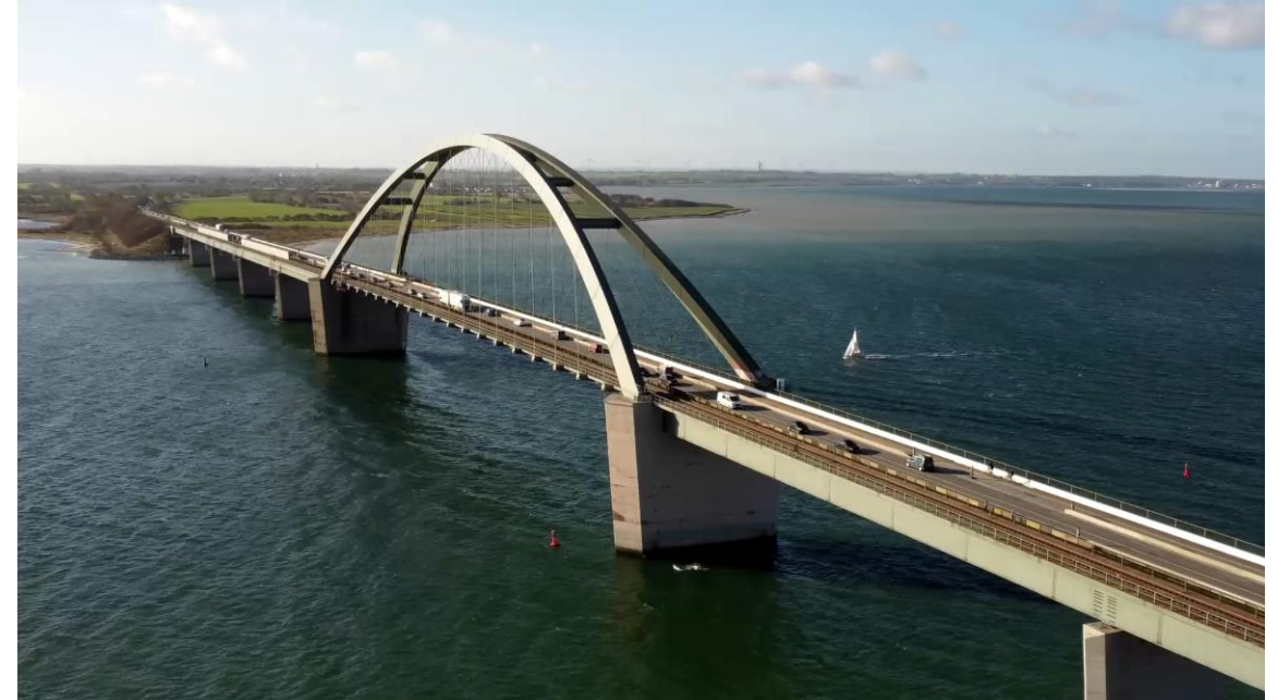
Einblicke in die Instandhaltungsarbeiten auf der Fehmarnsundbrücke
