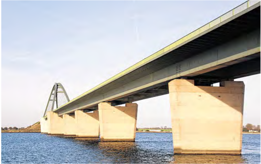
Am Montag dieser Woche diskutierten 30 Vertreter auf Einladung von Landesverkehrsminister Meyer auf Fehmarn über die Zukunft der Fehmarnsundbrücke.
