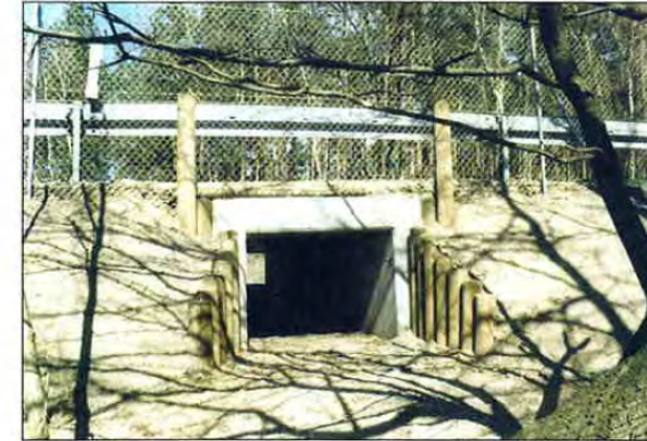
Bild 17: Trockendurchlass für Fischotter mit Sperrzaun
